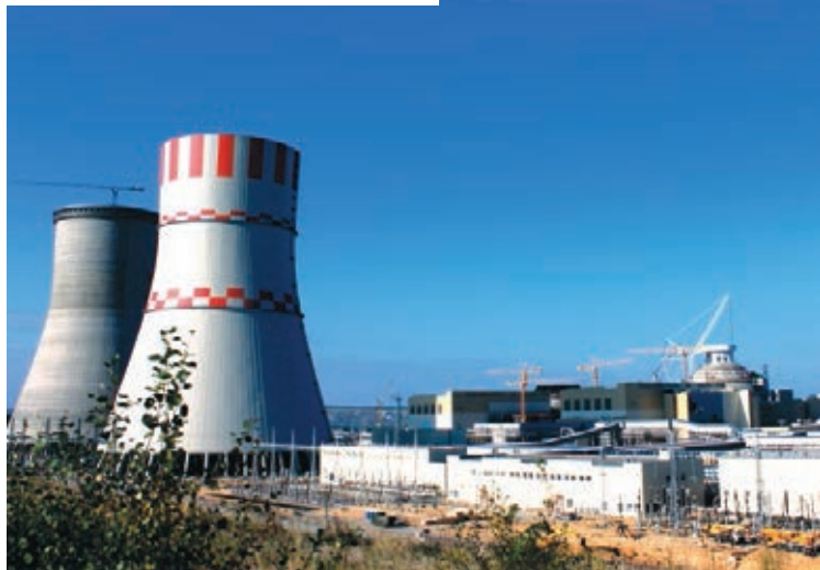
АЭС на стадии строительства
